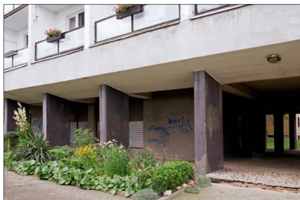
96. Výzvou je ochrana a obnova dochovaných proků parteru a jejich původních kvalitních detailů, hrozbou jejich znehodnocení dostavbami a novodobými, méně trvanlivými materiály. Volný parter s průchodem, moderním podloubím a obkladem ze skleněné mozaiky je skvělým dokladem humanistických 60. let, orchole fáze výstavby našich sídlšť, proto by měl být zachován a citlivě opraven. Mělník. Foto: Hana Řepková, 2020.
