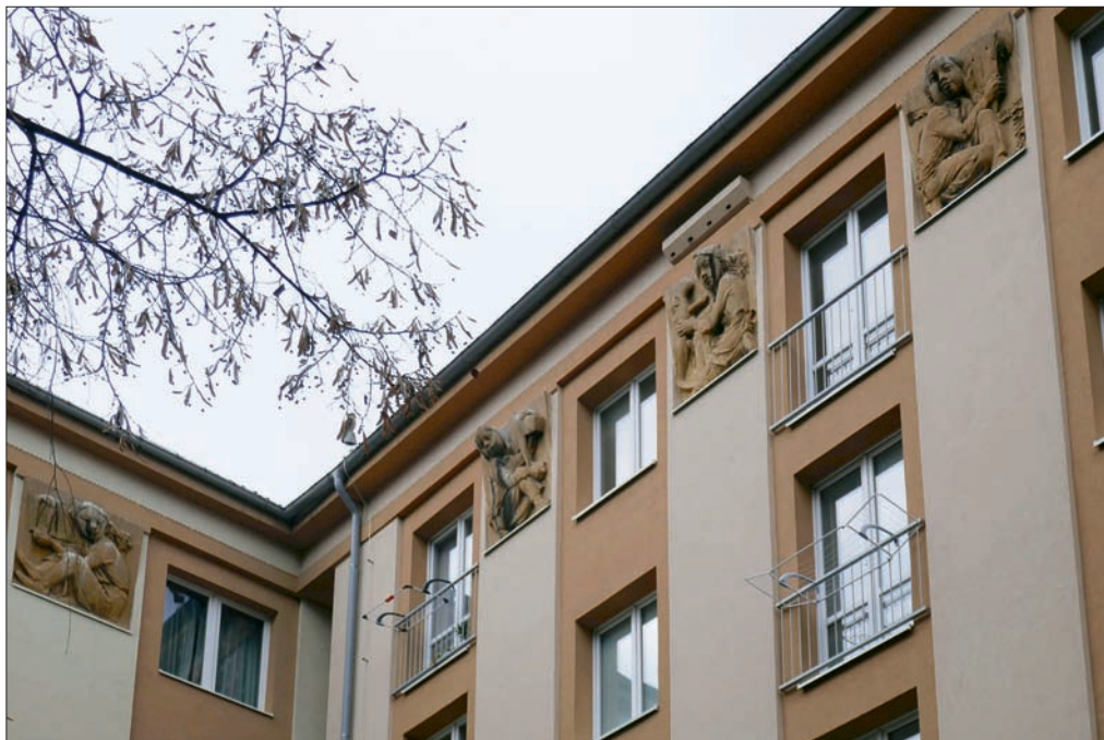
68. Pro soubor bytových domů ve stylu sorely podél Ruské ulice v pražských Vršovicích jsou typické velkoformátové reliéfy osazené na průčelí pod římsou v pozici hlavic. Dům má společnou prádelnu i sušárnu, přesto na zábradlí vznikají bizarní konstrukce na prádlo. Průčelí je orientováno do vzrostlé zeleně, nekulturnost dodatečných konstrukcí kazí dojem z dobré architektury s umělecky ztvárněnými reliéfy hrajících si dětí. Praha 10 – Vršovice, Jakutská 1201/13 a 1202/15. 50. léta 20. století. Foto: Hana Řepková, 2021.
