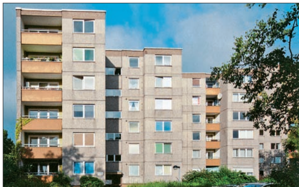
112. V Německu mají nástaovy panelových domů modernistických sídlišť nejčastěji ploché střechy. Neviditelná nástaoba půdorysně členitého panelového bloku ze 70. let. Principem je opět návrat ke kořenům, k bílému funkcionalismu. Šestipodlažní blok získal další, téměř identické patro s výrazně vyloženou střechou. Nová okna mají tmaově šedou barvu, lodžie se opticky prohloubí, okna nespřlývají s fasádou, ale zdobí ji. Snímek (a) zobrazuje stav před regenerací, (b) s nástaobou a do boku otevřenou lodžii v posledním patře. Německo, Berlín, Wohnpark Mariendorf. Přeuzato z: Hunger/Weidemüller/Protz 2018.
