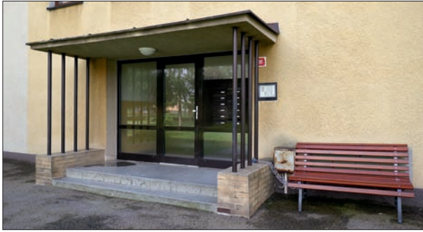
89. Mřížovina lemuje prosklený vestibul, obojí je v původní efektivní černé barvě typické pro 60. léta, 20. století, zachována zůstala i kvalitní břizolitová omítka a kabřincový obklad soklu. Týnec nad Sázavou, Komenského 281. Foto: Hana Řepková, 2021.
