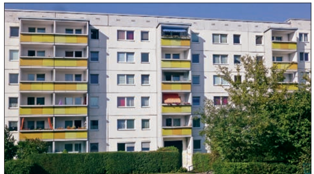
332. Na nezatepleném panelovém domě se za vysokou atikou s větracími otvory skrývá dvouplášťová střecha. Německo, Berlín, sídliště Hellersdorf, část Gelbeviertel. Foto: Hana Řepková 2018.
