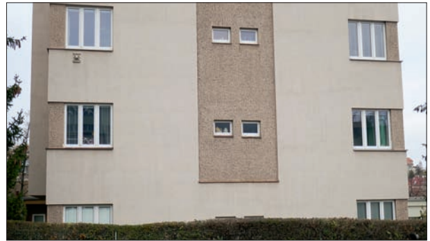
91. Omítky v přírodních odstínech měly různou strukturu, hrubou na větších plochách, hladkou na římsách, okenních šambránách, vstupních portálech, ale i sloupcích zábradlí. Odolena Voda, sorela. 50. léta 20. století. U modernistických staveb byly rozdíly struktur využívány pro architektonicky kontrastní působení ploch (a). Praha-Břevnov. 30. léta 20. století. Nátěr fasády umocňuje kontrastní působení odlišných struktur. Jedná se o nepřesné čtení původního vzhledu, kdy hrubá struktura působila jako tmauší (b). Foto: Hana Řepková, 2021 a 2020.
