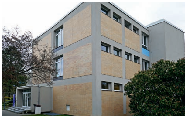
150. Obnovení původního obkladu na zateplení. Praha-Suchbát, kampus Zemědělské univerzity. 60. léta 20. století. Foto: Hana Řepková, 2020.
