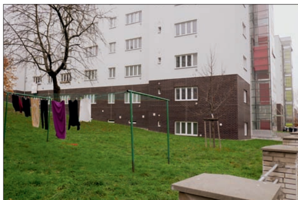
67. V malobytové kolonii na Břevnově měl každý dům svou prádelnu a sušárnu, dodnes se suší i mezi bloky. Praha 6 – Břevnov, Nad Kajetánkou. Foto: Hana Řepková, 2020.
