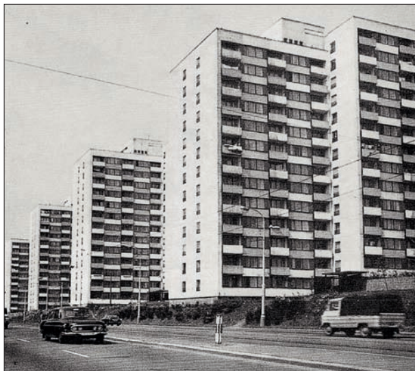
187. Černobílá šachovnice domů soustavy Čapek na sídlišti Červený vrch: parapety a mírně zasunutá čela lodžii byly střídavě bílé a šedé, okení rámy černé. Praha 6 – Vokovice, Milan Jarolím 1960–1972. Průhled Eoropskou k severozápadu. Přežato: sine 1972–1979
