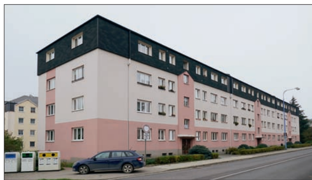
107. Zcela nevhodné jsou četné mansardové nástavby bytových domů. Dům opticky nezmenší, ani jej neučiní více městským. Úpice. 2. pol. 20. století. Foto: Hana Řepková, 2020.
