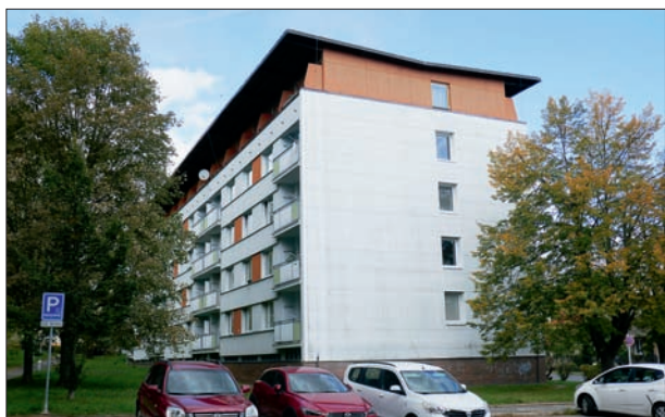
114. Kultivoovanou ukázkou, jaké střechy panelákům sluší, je Haolíčkův Brod. Kromě plochých střech a ustupujících podlaží výborně pasují střechy opačného sklonu, užívané u nás v 60. letech – snímek štítu (a) a hlaoního průčelí (b). Haolíčkův Brod. 80. léta 20. století. Foto: Hana Řepková, 2021.
