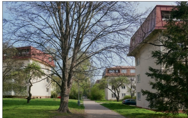
105. V 90. letech získalo dvouletkové sídliště v Kobylisích namísto valbových střech nástavby kapotované falešnými mansardami. Jedinou výhodou neforemných nástaveb bylo, že celý soubor získal opět jednotné řešení. Praha 8 – Kobylisy, Služská ulice. 40. léta. 20. století. Foto: Hana Řepková, 2022.
