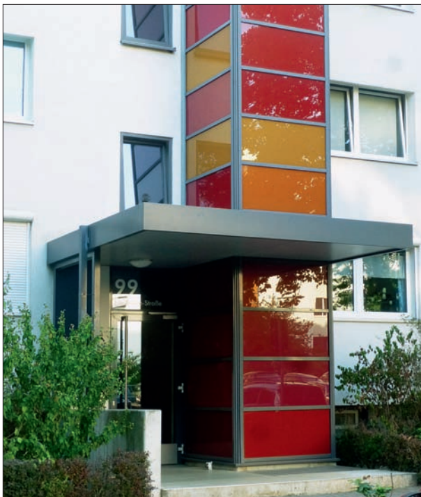
312. Bílé průčelí je ozdobeno prosklenými újtahy v různých kombinacích červených, oranžových a okrových tabulí. Do tělesa újtahu je kotoena nová markýza. Německo, Berlín, sídliště Hellersdorf, Roteoiertel. Foto: Hana Řepková 2018.
