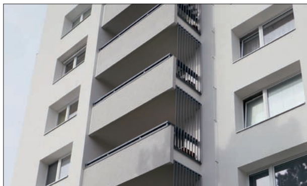
149. Obnovení mřížoviny na balkonech. Liberec, sídliště Králův Háj čp. 557, Aloisina výšina 54. 60. a 70. léta 20. století. Foto: Hana Řepková, 2017.
