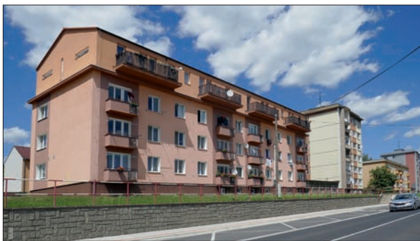
106. Nevhodné je i nahrazování valbové střechy sedlovou. Dům opticky nezmenší ani jej neučiní více městským. Beroun. 50. léta 20. století. Foto: Hana Řepková, 2021.
