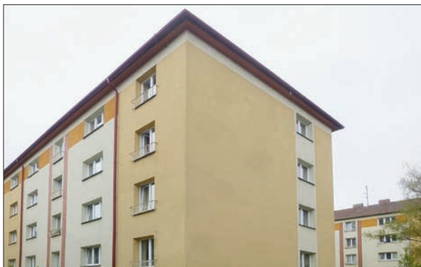
159. Jednobarevné břizolitové omítky byly po zateplení doplněny o průběžný pás pod římsou, barevně odlišené „půdní patro“, ostupy lemují cihelné lisény. Tradiční odstíny souboru pomáhají začlenit se do čtvrti s velmi kvalitní architekturou. Praha 6 – Dejičice čp. 1990–2002, Zelená 21–27. 40. léta 20. století. Foto: Hana Řepková 2019.
