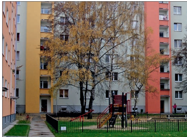
230. Schodišťové věže panelových domů typu G 57 byly zvoleny pro oživení fasád jako typický proek této soustavy odlišující ji od pozdějších typů panelových soustav. Celý blok v Brunclíkově byl řešen naráz (na rozdíl od bloku v Šantrochově a dalších), na zeleno-šedé fasádě se střídají okrové věže s červenými. Praha 6 – Břevnov, sídliště Petřiny, čp. 1756–1761, Brunclíkova 16–26, pohled z vnitrobloku. Evžen Benda, 1961–1965. Foto: Hana Řepková, 2003.
