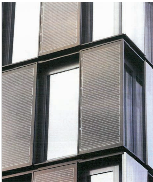
330. Solární panely většího formátu jsou použity namísto mezikenních vložek. Obdobné řešení vyvinuté v devadesátých letech u nás nebylo realizováno. Jedná se o jeden z příkladů současného využití této myšlenky a ověření jejího architektonického působení, nikoli o doporučení nebo dokonce závazné řešení. Převzato z: https://t-power.cz/ , vyhledáno 12. 12. 2022.
