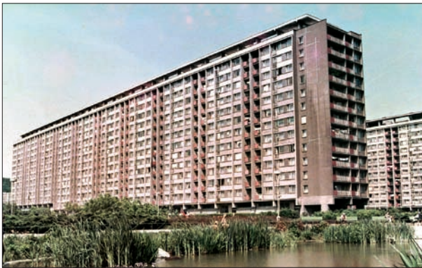
137. Cenné a ve velké míře intaktní soubory je třeba chránit a obnovit. V Praze se jedná mimo jiné o sídliště Invalidovna či Dáblice. Praha 8 – Kobylisy, sídliště Dáblice čp. 1140–1149, Famfulíkova 1–19, Viktor Tuček 1968–1975. Foto: Zdeněk Voženílek, 70.–80. léta.
