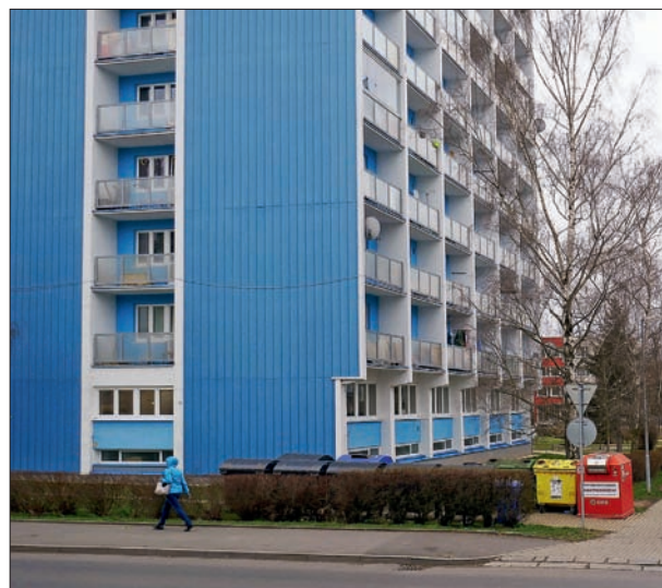
192. Tři chodbové věžové domy z konce 60. let byly v 90. letech zatepleny obkladem Feal. Na rozdíl od stěrky, jejíž povrchová úprava se špiní a bledne (vymývá), je barevnost lamel Fealu je i po desetiletích velmi uspokojivá. Rakovník, sídliště V Lukách, Dukelských hrdinů čp. 1773, 1782, 1804. Foto: Hana Řepková, 2019.
