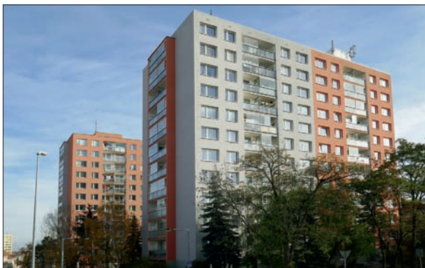
231. Ukázka realizace dle Generelu barevnosti vybraných obytných souborů na území městské části Praha 6: Optické zmenšení dvojice výškových deskových domů hmotově a měřítkově rušivých. Snížení výšky většinou nefunguje, zeštíhlení ano. Obě velké deskové hmoty byly opticky rozděleny na čtyři vysoké štíhlé, dvojbarevnost jediného bloku je vyvážena zopakováním téhož řešení v pozitivu a negativu. Kontrastní průčelí obou částí dvojdomu může působit, jako by byla půdorysně mírně posunuta. Praha 6 – Břevnov, bloky čp. 136–138, Radimova 27 a 29. Foto: Hana Řepková, 2020.
