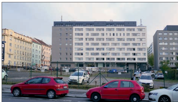
154. Domy celé skupiny jsou řešeny v jednotící koncepci. Praha 3 – Žižkov, Roháčova 28–50. Pohled z Koněvovské ulice. Miroslav Baše, 80. léta, Regenerace ateliér MS, 2010. Foto: Hana Řepková, 2021.
