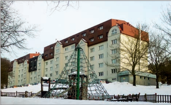
341. „Humanizační“ nástavba na bytovém domě z 80. let ho nezmenší ani neučiní krásnějším. Tento způsob regenerace se neosvědčil.
