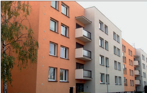
176. Barva důsledně sleduje hmotu domu. Praha 6 – Břevnov, soubor Bolívarova. 70. a 80. léta. Foto: Hana Řepková, 2012.
