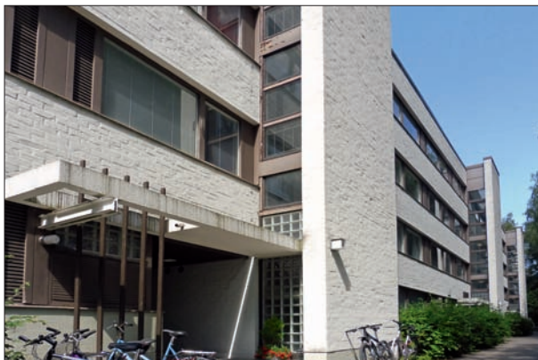
325. V severských zemích se téměř nezatepluje, izolační vrstva mezi panely, používaná i u nás, je tamními odborníky vyhodnocena jako dostatečná. Dodnes se jako finální vrstva používají režné panely s otláčným vzorem. Na snímku fasáda z režného cihelného zdiva opatřená bílým nátěrem. Finsko, Helsinky, soubor Tapiola, 60.–70. léta 20. století. Foto: Hana Řepková, 2020.
