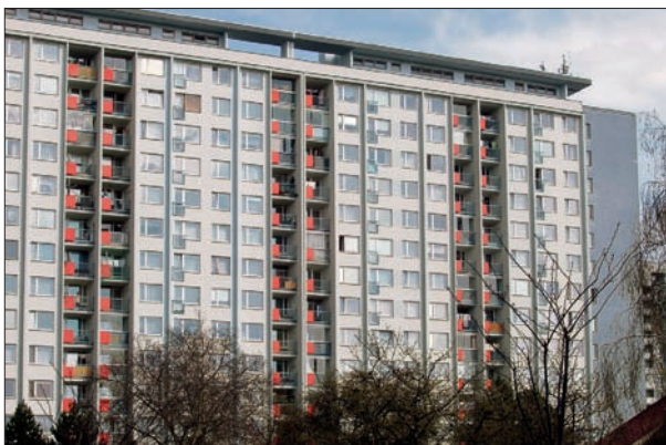
225. Jeden z bloků, jehož zateplení bylo realizováno podle barevného generelu v šedomodré barvě. Řešení podtrhuje působení červených mozaikových zbradlí. Praha 8 – Kobylisy, sídliště Ďáblice, Vilém Hess, J. Schneider, 1969. Blok čp. 1296–1307, Frýdlantská 2–24. Návrh barevnosti Viktor Tuček ml., Hana Řepková. Foto: Hana Řepková, 2012.
