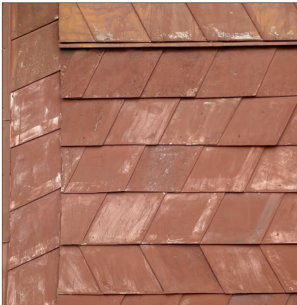
326. Starší typ zateplení, obklad štítu eternitovými šablonami. Šablony několika tvarů a formátů lze skládat různými způsoby. Kombinovat lze šablony několika barev. Pro moderní architekturu je vhodnější jednobarevná fasáda, zdálky jednotná, zblízka strukturovaná. Výhodou je trvanlivost a stálobarevnost. Na snímku cca 100 let starý obklad štítu, šedý eternit byl přetřen načerveno. Lipová-Lázňe. Foto: Hana Řepková 2021.
