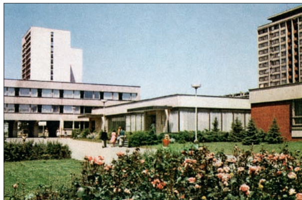
188. Převažující bílá barva, s černými doplňky a červenými akcenty. Černé okení rámy a meziokenní oložky, cihelný obklad fasád (pošta) a červené mozaikové čtverce lodžii. Praha 8 – Kobylisy, sídliště Ďáblice, Viktor Tuček, Antonín Vranka, Jiří Kulišťák 1968–1975. Průhled Burešovovou ulicí k severu. Přežato z Tuček 1984.
