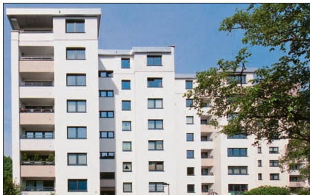
112. V Německu mají nástaovy panelových domů modernistických sídlišť nejčastěji ploché střechy. Neviditelná nástaoba půdorysně členitého panelového bloku ze 70. let. Principem je opět návrat ke kořenům, k bílému funkcionalismu. Šestipodlažní blok získal další, téměř identické patro s výrazně vyloženou střechou. Nová okna mají tmaově šedou barvu, lodžie se opticky prohloubí, okna nespřlývají s fasádou, ale zdobí ji. Snímek (a) zobrazuje stav před regenerací, (b) s nástaobou a do boku otevřenou lodžii v posledním patře. Německo, Berlín, Wohnpark Mariendorf. Přeuzato z: Hunger/Weidemüller/Protz 2018.
