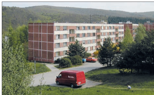
189. Červené síťové panely, meziokenní vložky a betonové zábradlí lodžii měly od počátku čtyřpodlažní domy sídliště Bystrc, dnes známého osobitými nástroby ateliéru Maura. Brno-Bystrc. Černého 52–56. 70. léta 20. století. Foto: Markéta Veselá, 2005.
