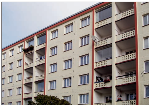
192. Tři chodbové věžové domy z konce 60. let byly v 90. letech zatepleny obkladem Feal. Na rozdíl od stěrky, jejíž povrchová úprava se špiní a bledne (vymývá), je barevnost lamel Fealu je i po desetiletích velmi uspokojivá. Rakovník, sídliště V Lukách, Dukelských hrdinů čp. 1773, 1782, 1804. Foto: Hana Řepková, 2019.
