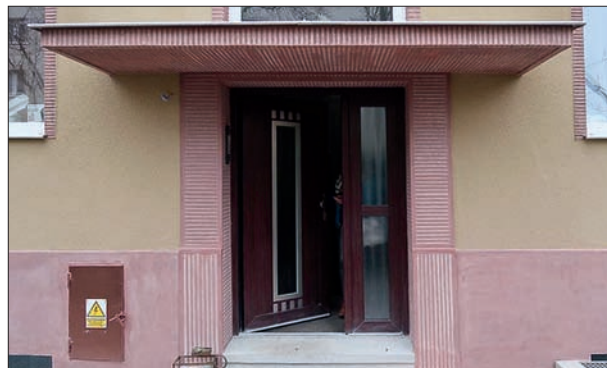
148. Příkladná restaurátorská obnova portálu památkově nechráněného objektu. Polsko, Gdyně, Krasickiego 38. 30. léta 20. století. Přežato z: https://www.whitemad.pl/budynek-z-lat-30-xx-wieku-gdynia/ , uhlédáno 8. 12. 2022.
