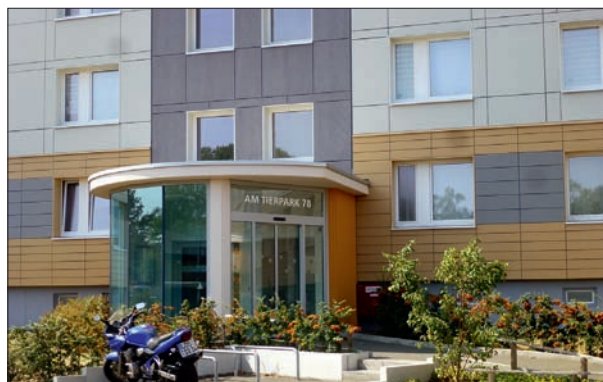
196. V rámci regenerace byly vyvoštěné domovní vchody zpřístupněny i rampami.
