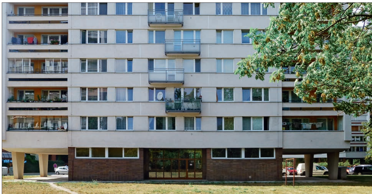
14. Panelové domy s kaštinovým obkladem parteru a pilířů z prostého betonu a nátěrem fasád, který nezatírá panelovou strukturu. Hradec Králové, Labská Kotlina II. Baarova 11, čp. 1378 pohled od jihozápadu. Foto: Hana Řepková 2020.
