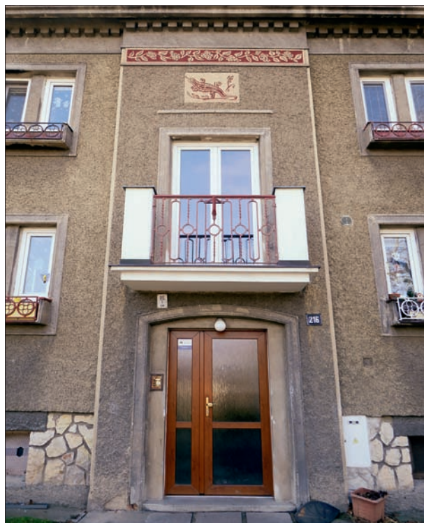
151. Zolášť důležité je respektování proků fasád souborů ve stylu socialistického realismu. Architektura, stavební detaily (např. zábradlí) a umělecká díla byly většinou vytvořeny autorsky právě pro daný soubor. Odolena Voda, Lidická 216. 50. léta 20. století. Foto: Hana Řepková, 2020.
