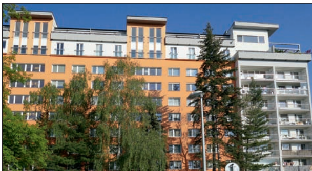
108. Nástavby více respektující modernitu panelových domů představuje sídliště Prosek. Nástavby osmipatrových domů zde nepřesahují půdorys, při štítech ustupují. Praha 9 – Prosek, Teplická ulice. 70. léta. 20. století. Foto: Hana Řepková, 2020.
