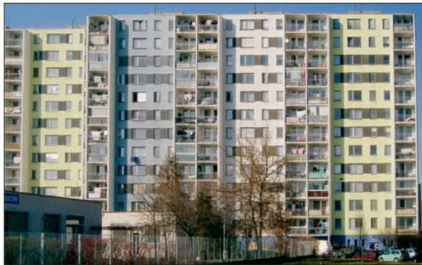
155. Jednotlivá okna jsou podle dvou schémat spojována šedou barvou fasády tak, aby evokovala podobu oken pásových. Praha 8 – Troja, sídliště Bohnice, blok čp. 491–505, Krynická 1–29. Zdeněk Jakubec, 70. a 80. léta 20. století. Regenerace fasád Hana Řepková 2000. Foto: Hana Řepková, 2022.
