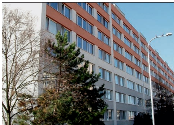
153. Bytové družstvo žádalo Oddělení architekta Odboru úřada obyvatelství MČ Praha 8 o souhlas se zateplením štítů, ale odmítlo předložit návrh řešení fasád celého bloku. Zateplení proto bylo povoleno s podmínkou, že zateplení štítů bude opatřeno omítkou v bílé barvě. O několik let později k ní byly navrženy podélné fasády. Praha 8 – Bohnice, sídliště Bohnice, čp. 563–567, Řešovská 20–28. Mílan Jarolím, 70. a 80. léta 20. století. Návrh nové barevnosti Hana Řepková, 2000. Foto: Hana Řepková, 2012.
