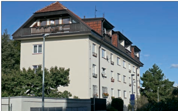
104. Nástavbami byly nejprve opatřovány domy dvouletkových souborů. Valbové střechy byly nahrazeny sedlovými střechami s polooalbou a dřevěnými proky. Toto řešení bylo cizorodé a neokusně rustikalizující. Praha 6 – Břeunov. 40. léta 20. století, nástavby 90. léta. Foto: Hana Řepková, 2020.
