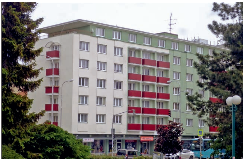
28. Bytový dům s akčním parterem a ustupujícím posledním patrem. Konstrukci tvoří montovaný skelet. Mladá Boleslav, třída T. G. Masaryka 1084–1086. Osvald Döberk 1956–1967. Foto: Hana Řepková, 2019.
