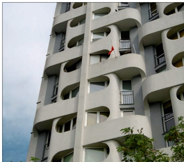
268. Šest domů s obchodním parterem, parkovacím polosuterémem a pavilony služeb a restaurací v organických formách tvoří soubor Plac Grunwaldski, zvaný též wrocławski Manhattan. Detail zateplené fasády – šedý nátěr fasády nahradil se souhlasem autorky původní keramický obklad. Polsko, Vratislav-Plac Grunwaldski, Jadwiga Grabowska-Hawrylak, 1968–1978. Foto: Hana Řepková 2019.
