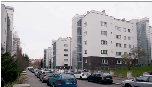
152. První dva domy břevnovského malobytového souboru ze 30. let orientované štítem do ulice Patočkova získaly přístavbu barevných úýtahů v roce 2005. Sousední domy na ně navázaly (a), domy orientované do ulice Nad Kajetánkou získaly přístavbu úýtahů zhruba o 10 let později, již v provedení z čirého skla kombinovaného s pískovaným (b).
