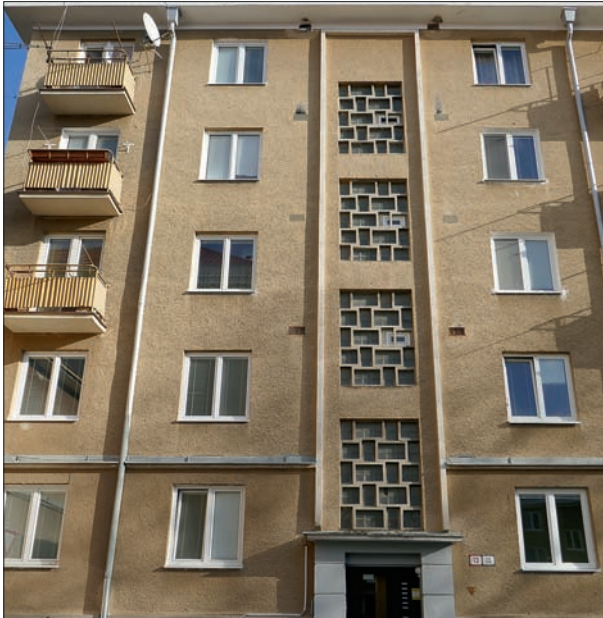
115. Výrazným prokem fasád jsou prosklená schodiště, zde ozdobná mřížovina vyplněná kombinací sklobetonových tvárnic a malých okének. Slovensko, Nová Dubnica. 50. léta 20. století. Foto: Hana Řepková, 2019.
