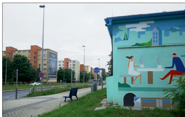
232. Koncepční řešení pětice deskových domů typu G 57. Průhled Evropskou třídou k západu. Objekt trafostanice je ukázkou, že kvalitní a vtipné dekorativní malby jsou v úrovni parteru zcela přípustné. Parter zpestří a v dálkových pohledech neruší. Praha-Vokovice, sídliště Červený Vrch, pohled k západu z křižovatky Evropské a Arabské. Foto: Hana Řepková, 2020.
