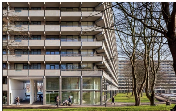
323. Množství průchodů blokem bylo zredukováno, byly však výrazně zvětšeny. Nizozemí, Amsterdam-Zuidoost, sídliště Bijlmermeer. NL Architects a XVW architectuur, 2017. Přežato z: Wilkinson 2017
