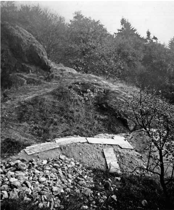
Obr. 8. Přimda, zřícenina hradu. Úprava terénu skládkou materiálu, vytěženého v roce 1971 z výkopu při východní straně donjonu, v poloze směrem na severovýchod od donjonu. V pozadí relikv obvodové hradby. Pohled od jihozápadu. Fotoarchiv Národního památkového ústavu, ú. o. p. v Plzni, foto J. Kočandrle, 1971)
