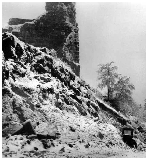
Obr. 3. Přimda, zřícenina hradu. Úprava cesty a východního svahu skalního hřebene. Pohled od jihu. (Fotoarchiv Národního památkového ústavu, ú. o. p. v Plzni, foto J. Pavlíková, 1968)
