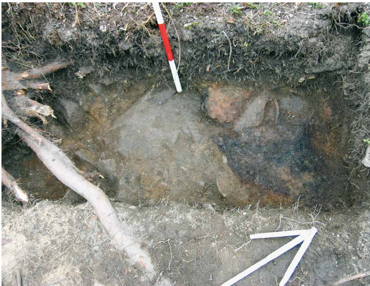
Obr. 17. Přimda, zřícenina hradu. Základový výkop pro nový objekt pokladny. Sonda II. Detail propáleného místa. Pohled od jihovýchodu. (Foto L. Foster, 2012)
