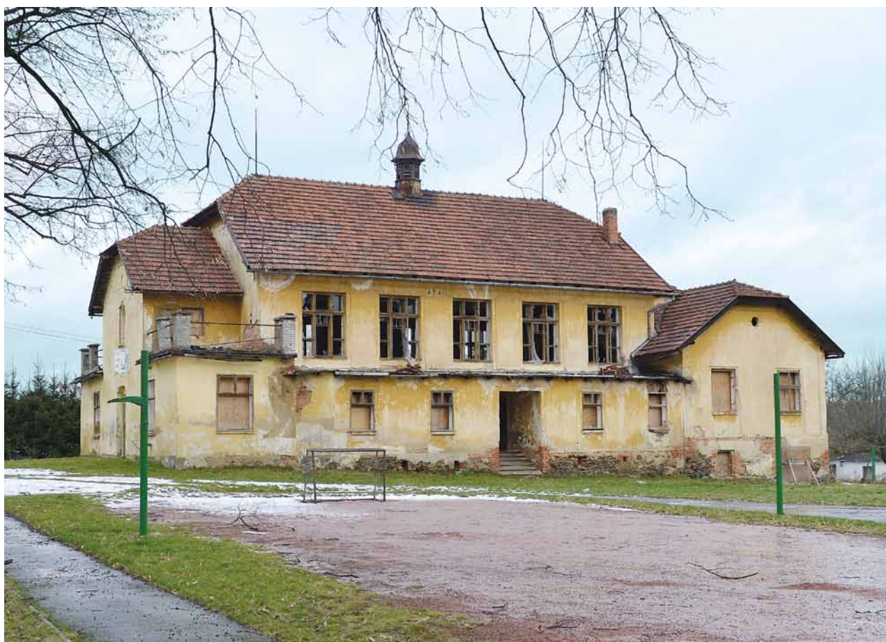
Obr. 1. Chudenice (okr. Klatovy), sokolovna čp. 136. Pohled od jihu. (Foto D. Tuma, 2012)
