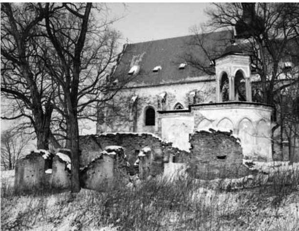
Obr. 20. Horšovský Týn, Na Vršíčku. Zříceniny posledního domku kostelníka u kaple Božího hrobu. Pohled od jihovýchodu. (Fotoarchiv Národního památkového ústavu, ú. o. p. v Plzni, foto K. Foud, 1991)
