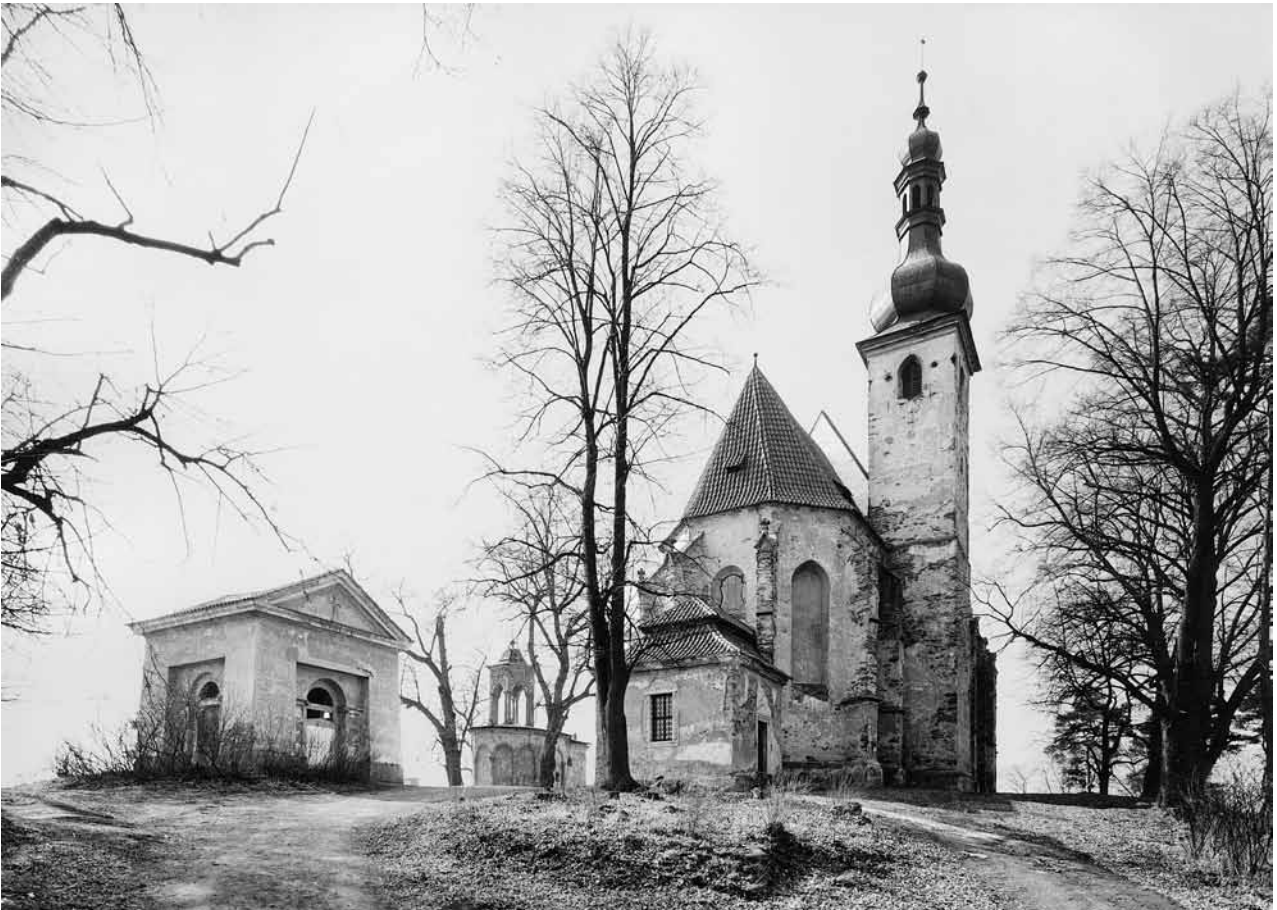
Obr. 1. Horšovský Týn (okr. Domažlice), Na Vršičku. Kostel sv. Anny, kaple Božího hrobu (uprostřed v pozadí) a malá trauttmansdorffská pohřební kaple (vlevo). Severovýchodní pohled; kostel a kaple Božího hrobu jsou orientované kultovní stavby. (Fotoarchiv Národního památkového ústavu, ú. o. p. v Plzni, foto J. Gryc, 1992)
