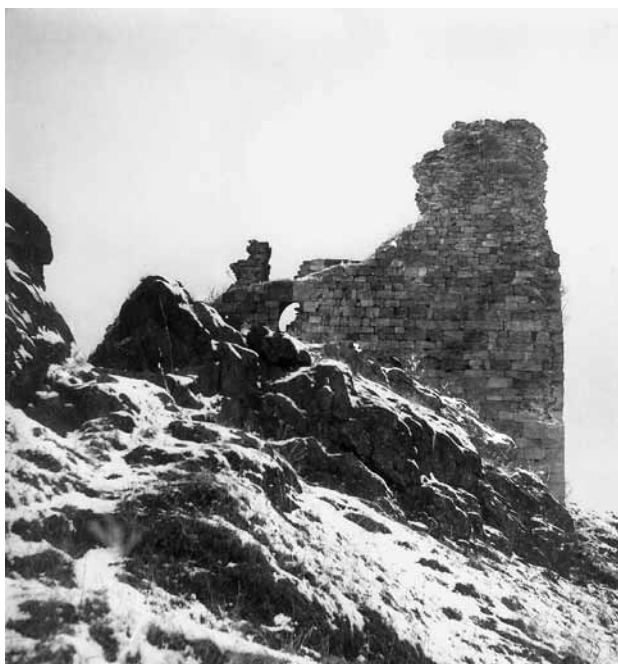
Obr. 2. Přimda (okr. Tachov). Zřícenina hradu. Pohled od jihu na horní část východní strany skalního hřebene v místech někdejší horní brány (vlevo). Ke skále dosud přiléhá suťový svah, odstraněný v roce 1968. (Fotoarchiv Národního památkového ústavu, ú. o. p. v Plzni, foto F. Bureš, 1962)
