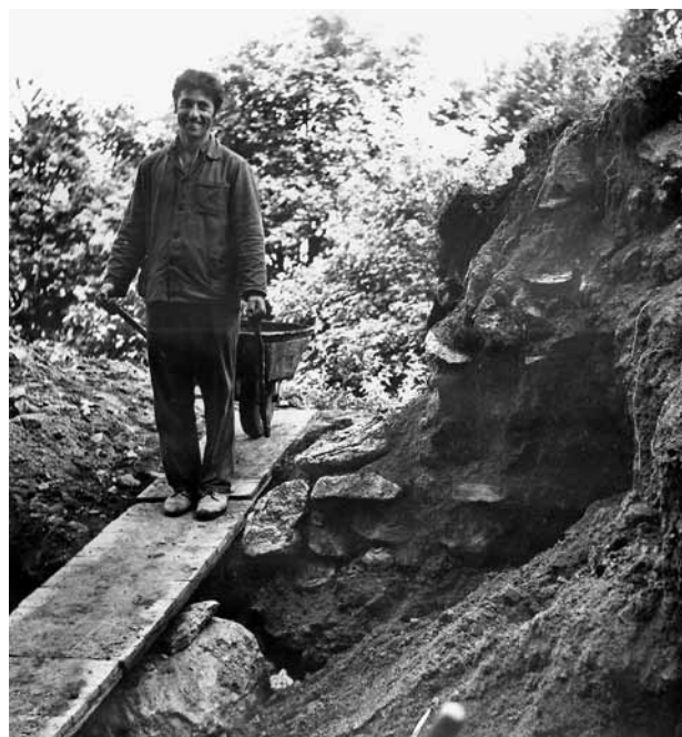
Obr. 5. Přimda, zřícenina hradu. Výkop při severní straně donjonu s odkrytou obvodovou hradbou. (Fotoarchiv Národního památkového ústavu, ú. o. p. v Plzni, foto J. Kočandrle, 1971)
