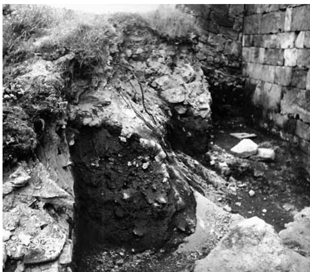
Obr. 4. Přimda, zřícenina hradu. Výkop při severní straně donjonu. Pohled od západu. Vlevo je vidět líc odkryté obvodové hradby. (Fotoarchiv Národního památkového ústavu, ú. o. p. v Plzni, foto J. Kočandrle, 1971)
