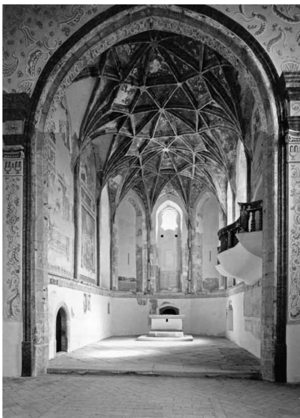
Obr. 23. Horšovský Týn, Na Vršíčku. Kostel sv. Anny. Pohled z lodi do chóru. Stav po dílčí památkové obnově provedené v roce 1991. (Fotoarchiv Národního památkového ústavu, ú. o. p. v Plzni, foto J. Gryc, 1993)
