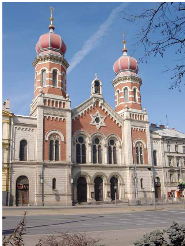
Obr. 7. Plzeň (Jižní Předměstí), Velká synagoga. Pohled od jihovýchodu. (Fotoarchiv Národního památkového ústavu, ú. o. p. v Plzni, foto R. Kodera, 2006)
