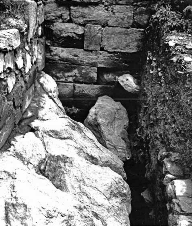
Obr. 12. Přímada, zřícenina hradu. Sonda I před jižní stranou přístavku (vlevo). V pravém profilu výkopu je zbytek mladšího zdiva. Pohled od západu. (Fotoarchiv Národního památkového ústavu, ú. o. p. v Plzni, foto J. Kočandrle, 1973)
