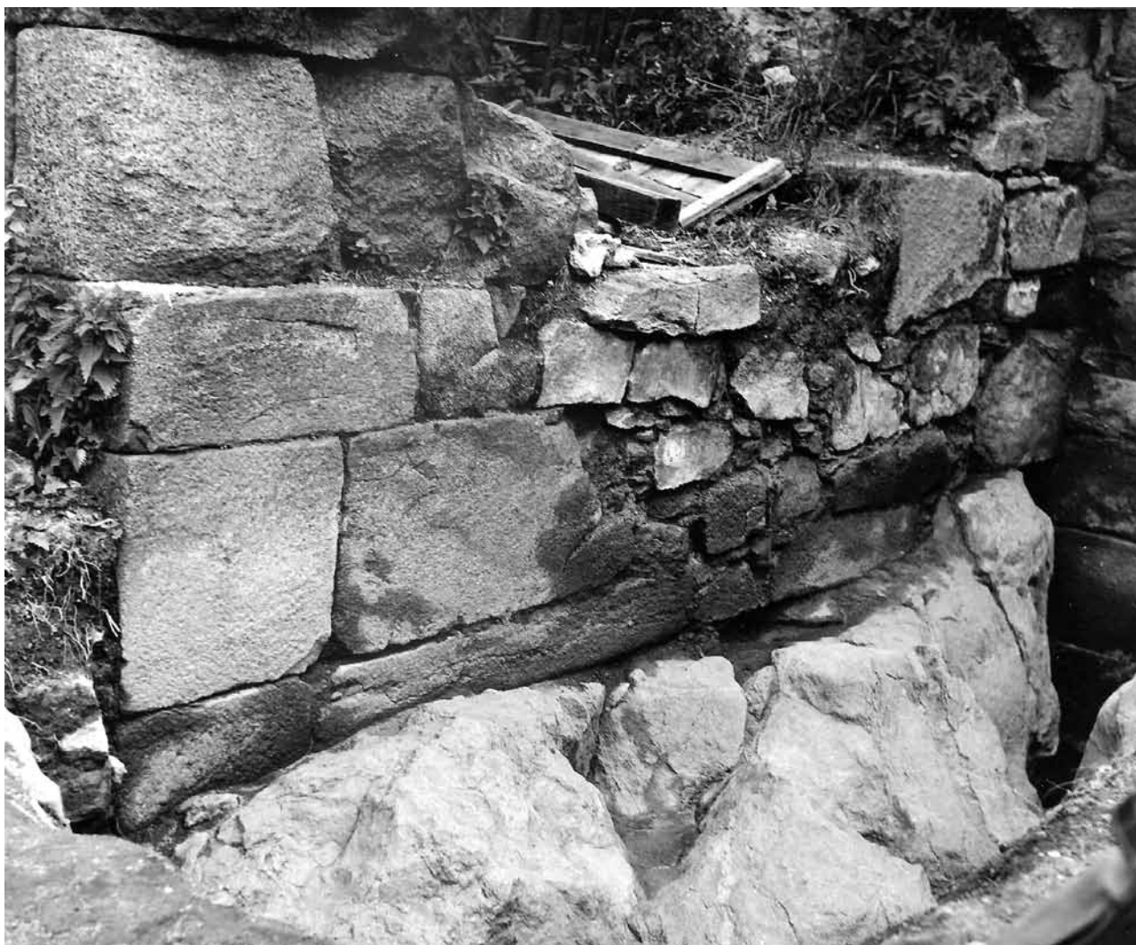
Obr. 13. Přimda, zřícenina hradu. Sonda I z roku 1973 před jižní stranou přístavku. Druhotná zadívka související zřejmě s dodatečným zřízením vstupu do přízemí. Pohled od jihozápadu. (Fotoarchiv Národního památkového ústavu, ú. o. p. v Plzni, foto J. Kočandrle, 1973)
