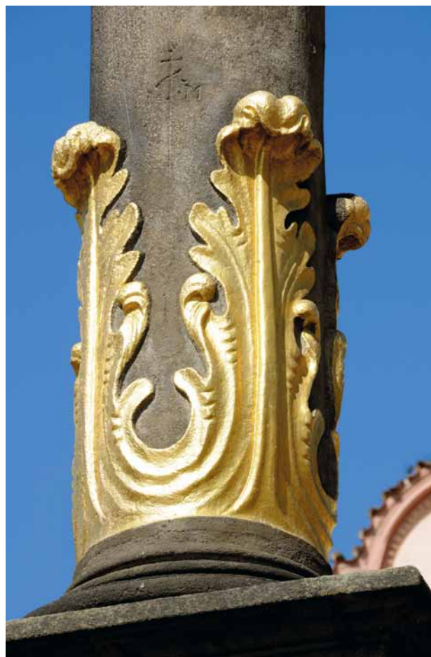
Obr. 3. Plzeň, náměstí Republiky, sloup se sochou Madony plzeňské. Spodní část dříku s kamenickou značkou Jana Mejlíka v úrovni těsně nad pozlacenými akantovými listy. (Foto V. Kovařík, 2014)
