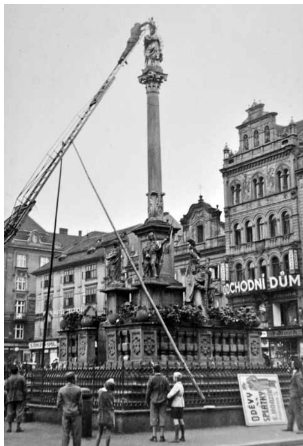
Obr. 9. Plzeň, náměstí Republiky, sloup se sochou Madony plzeňské. Pohled od severovýchodu. Dokončovací restaurátorské práce na kovových prvcích mariánské sochy v roce 1931(?). (Archiv města Plzně, foto b. a., asi 1931)
