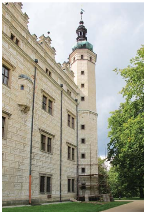
Stavba lešení pro restaurování sgrafit na zámku Litomyšl
