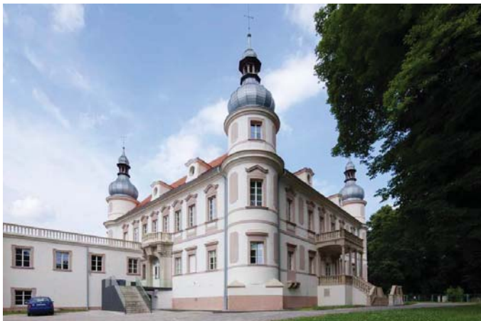
Budova nového zámku Krásné Březno (sídlo ÚOP)
