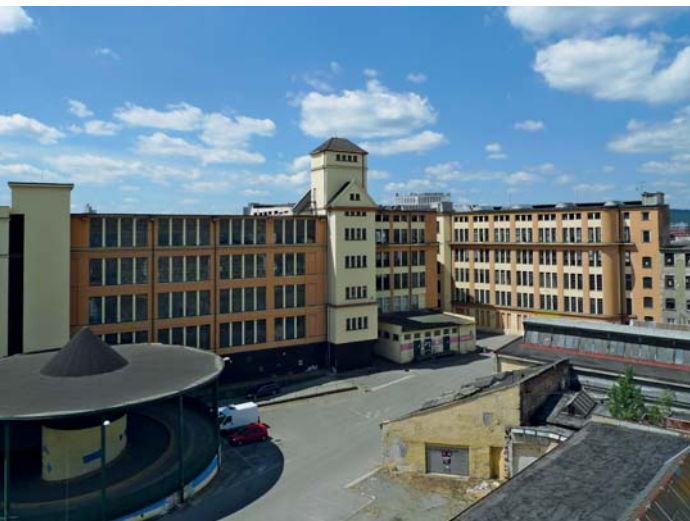
Jedním z projektů Metodického centra průmyslového dědictví v roce 2014 byla dokumentace brněnského vlnářského průmyslu – na snímku bývalá továrna na vlněné zboží Paul Neumark
