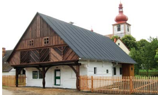
Radim čp. 41 před rekonstrukcí a po ní
