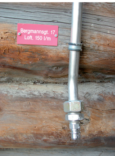
Obr. 4. Přípojné místo systému vysokotlaké mlhy na historické budově
