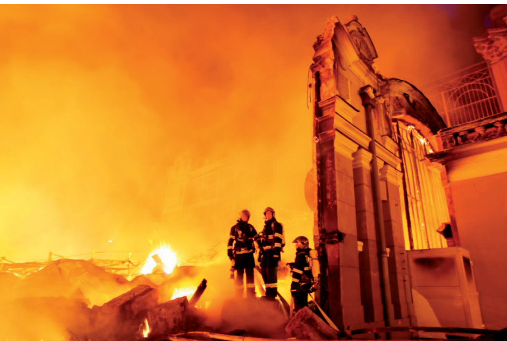
Obr. 1 Požár objektu Průmyslového paláce, Foto J. Chalabala, 2008
