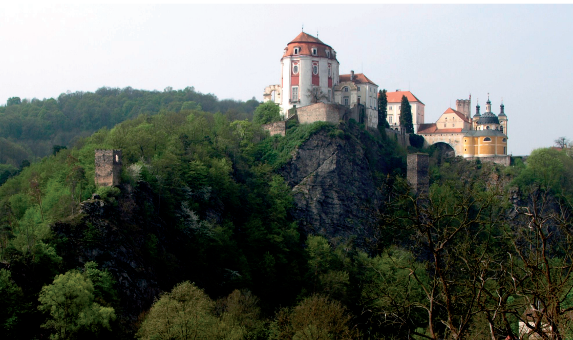
Obr. 1 Zámek Vranov nad Dyjí patří k objektům, jehož poloha na vyvýšeném skalním ostrohu jej činí téměř nedostupným pro těžkou hasební techniku.
