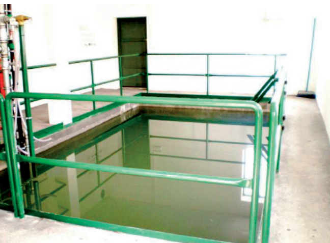
Obr. 2 Požární nádrž na zámku Bečov nad Teplou. (foto: J. Zelinger)
