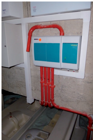
Obr. 6 Vyhodnocovací jednotka nasávacího hlásiče.
