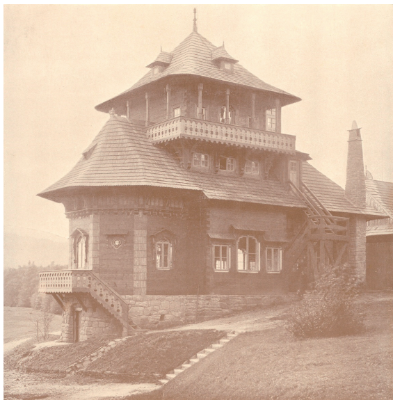
Obr. 7 - Historický snímek Libušina s původním umístěním komínu vně budovy [2]
