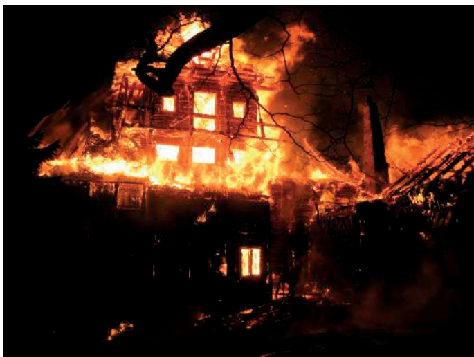
Obr. 2 - pohled na hořící objekt ze zadní strany (zdroj: foto HZS ZLK)
