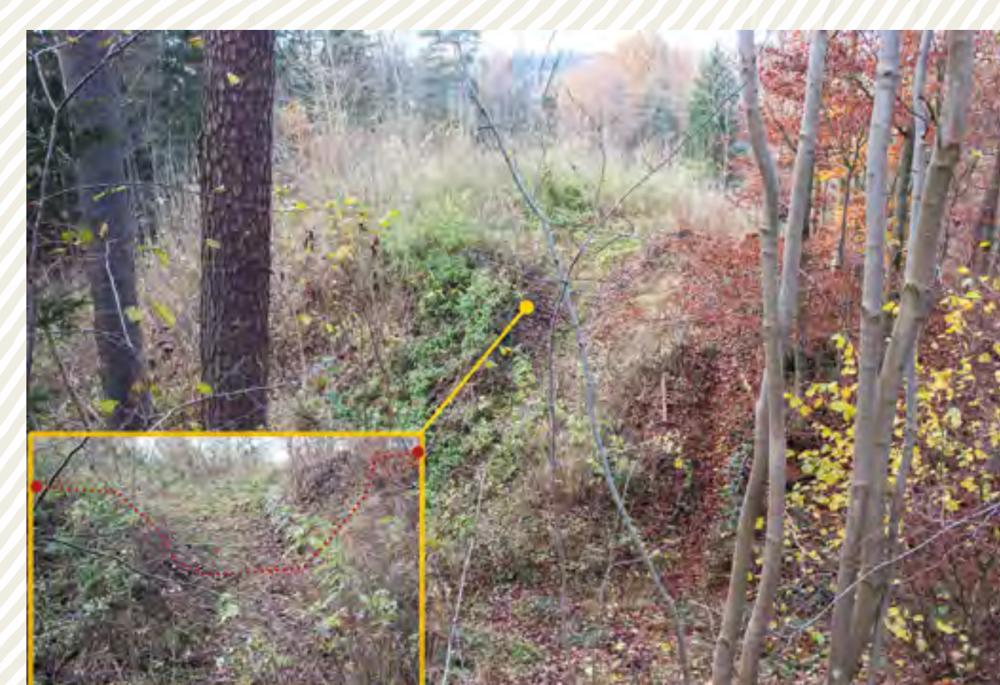
Obr. 4. Ostrolovský Újezdec (okr. České Budějovice). Na vyvýšeném tvrzišti (místo, kde se ve středověku nacházela tvrz) Újezdec byl vykácen lesní porost. Během svozu dřeva došlo k poškození přístupové části lokality. Celkový pohled na tvrzíšti s patrným zásahem (nově projezděnou cestou). Ve výřezu je detailní pohled na poškození, červeně je vyznačen nový profil cesty, zahlubující se do původních terénů
