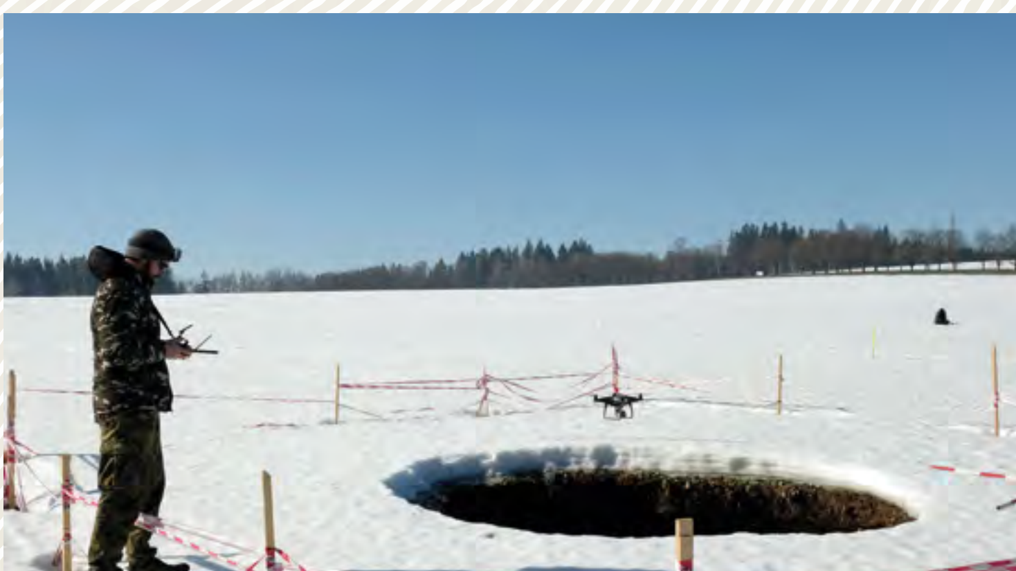
Obr. 7 – Údavy, operativní dokumentace propadlé šachty z bezpečné vzdálenosti. Foto: V. Pavelka, 2019
