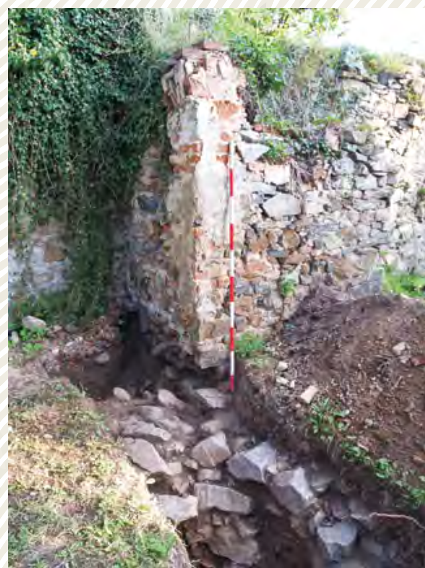
Komunikaci mezi jednotlivými terasami Horní užitkové zahrady umožňovaly také schodiškové věžice. Zazděný oblouk v jedné z nich a mohutná základová konstrukce zachycená archeologickou sondou ukazují, že v tomto případě na věžici navazovala další dnes již zaniklá stavba neznámého účelu
