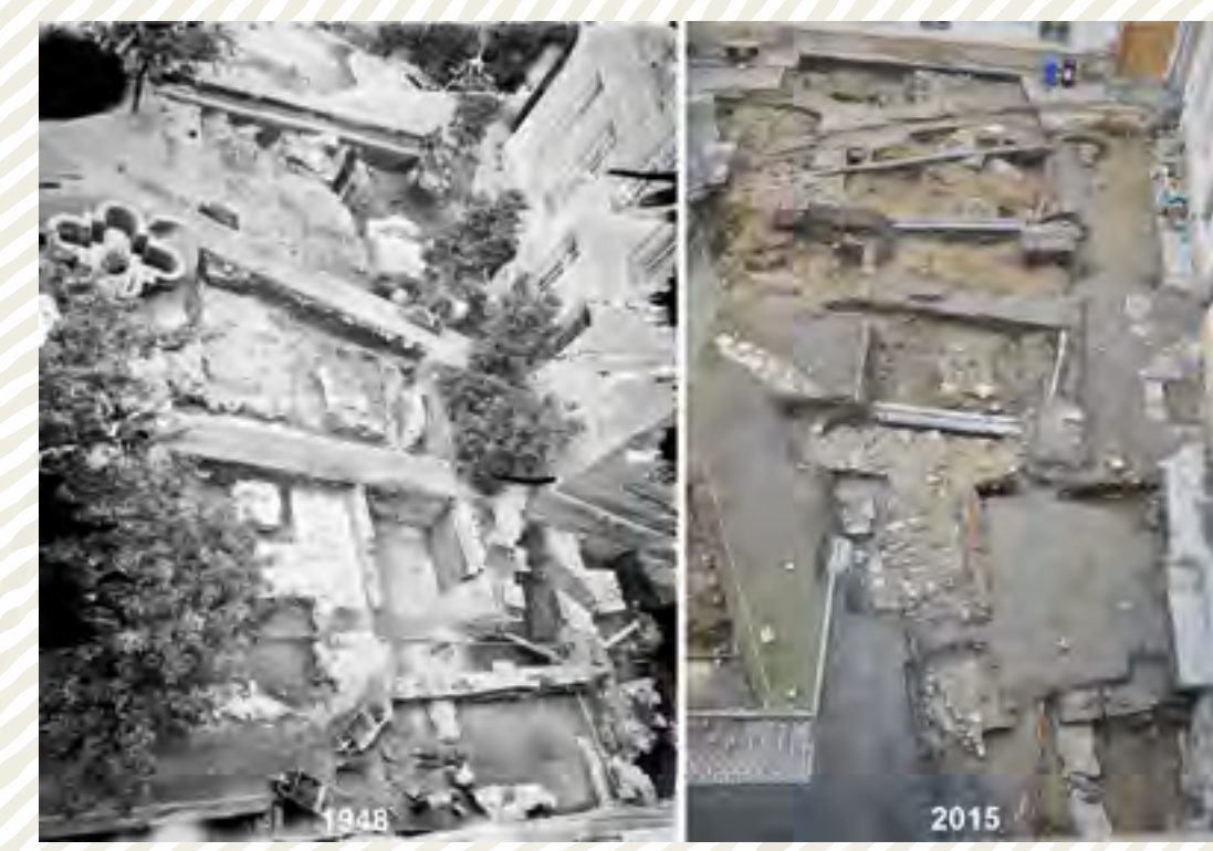
Obr. 6: Pohled na základové zdivo kostela sv. Petra odkryté v roce 1948 (vlevo) a 2015 (vpravo) 5
