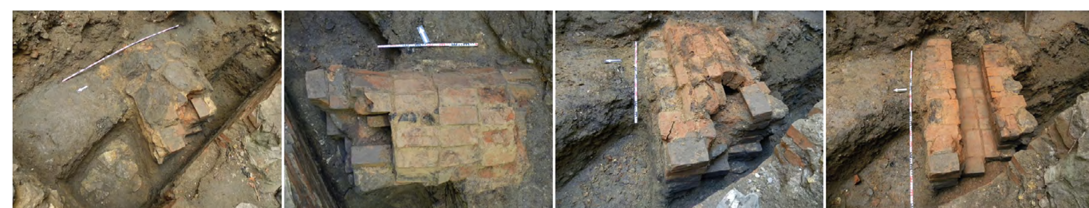
Pozůstatky hvozdové pece před rozebráním a v průběhu exkavace. Odhalené potravinářské zařízení bylo postaveno z cihel o formátu 27×13×7,5 cm spojených jílovou maltou. Rub půlkruhově klenuté klenby pece byl omázan jílem a obložen plotnami lomové břidlice
